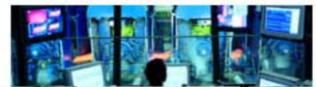
Elektrik und Automation
